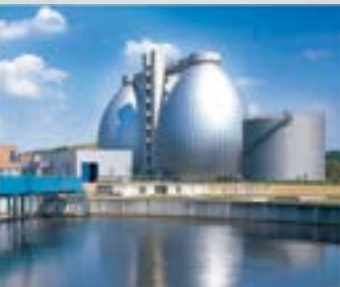
Su / Atık su istasyonu
